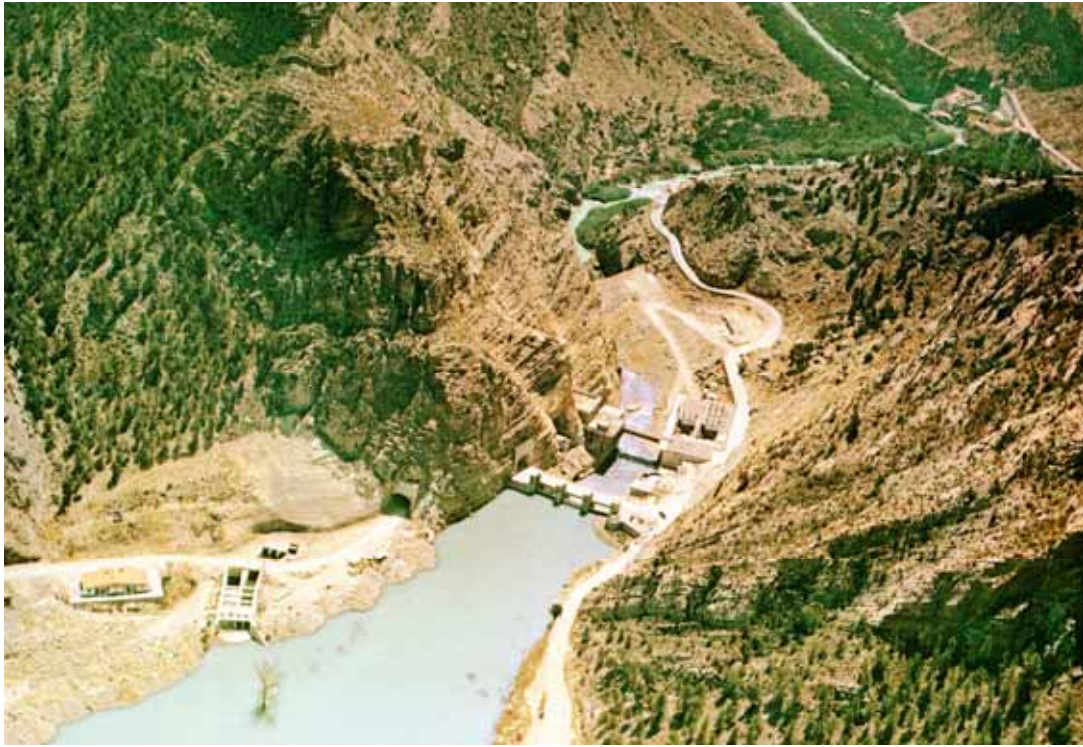
Foto 5. Vista aérea del Estrecho de Solvente (Azud de Ojós).
